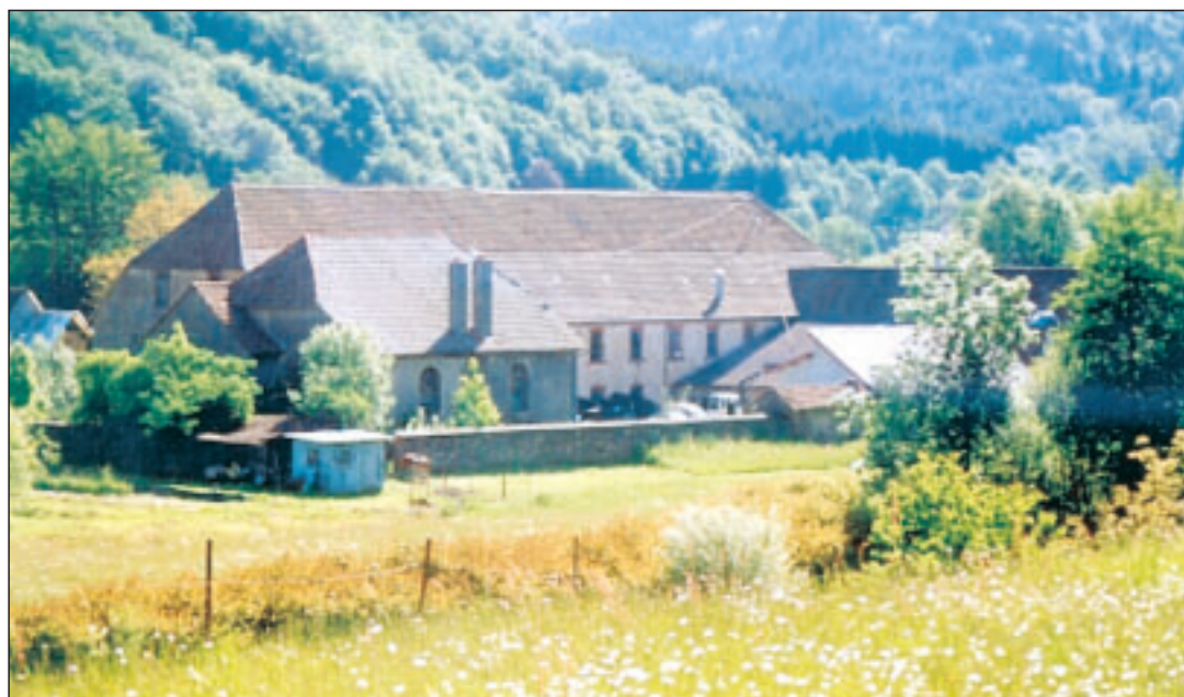
Ces anciens bâtiments abritaient jadis la manufacture royale de Wegscheid, fermée en 1838 et transformée en tissage qui, à son tour, cessa toute activité en 1952.
